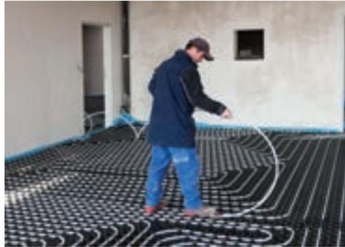
Installation de flexibles de chauffage par le sol. Le tapis permet de maintenir les tuyaux en place avant de couler la dalle.
